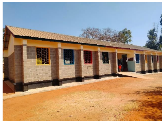
新たに建設された校舎
