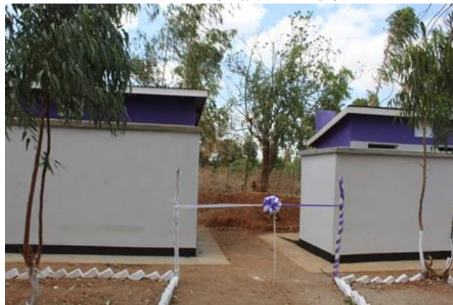
完成した女子トイレおよび着替え室
