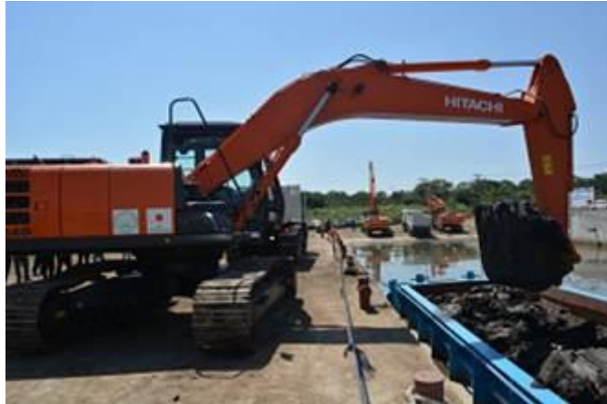
浚渫した土砂を船からトラックへ運ぶ掘削機
