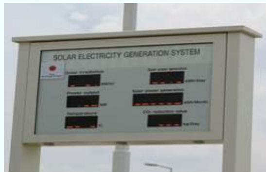
発電量を表示する電光掲示板
