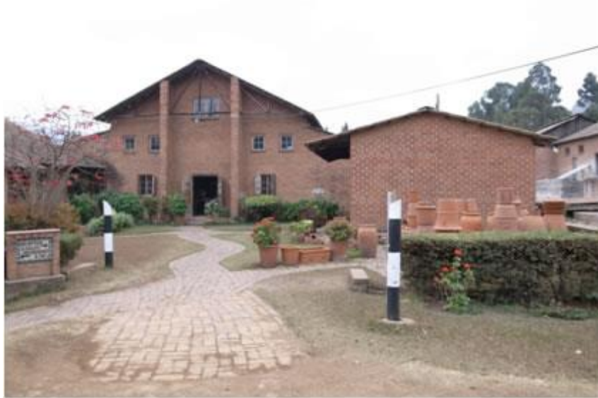
デッツァ・ポッターリー れんが造りの工房兼販売所
